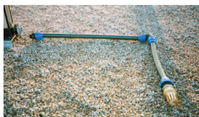
Montagem da tubagem de sucção
